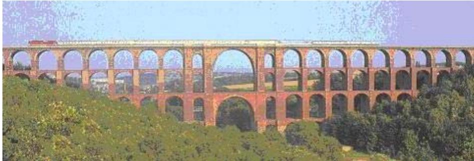
Das Volumen des Ziegelsteinmauerwerkes beträgt  $71\,671\text{ m}^3$ , das sind 52,83 % des Gesamtvolumens. 11,60 % des Gesamtvolumens ist Bruchsteinmauerwerk. Der Rest ist Werksteinmauerwerk.
